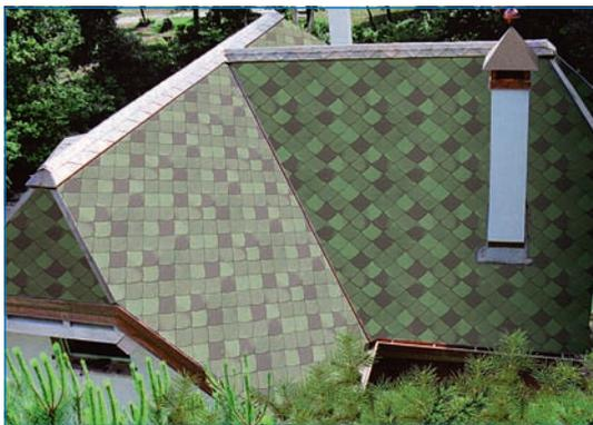
При укладке черепицы на скатах при уклоне больше 60° лист должен крепиться 6 гвоздями (2 дополнительных гвоздя фиксируют верхние углы листа на расстоянии от краев 2,5 см).
